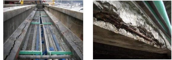
PC橋の塩害劣化の例(新潟県糸魚川市)
