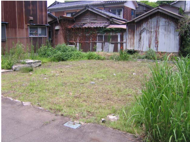
資材搬入通路になる隣接敷地の草むしり
