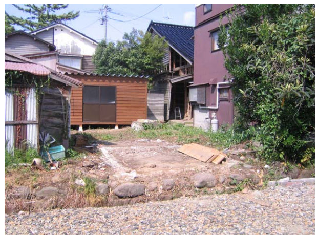
資材搬入通路完成（奥正面は新規収納小屋）
