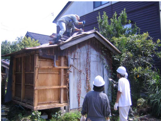
通路部分の小屋の解体作業
