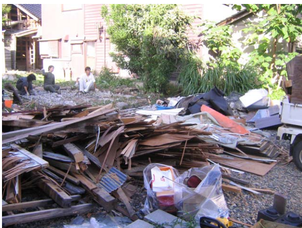
同上の廃材は処分場へ運搬
