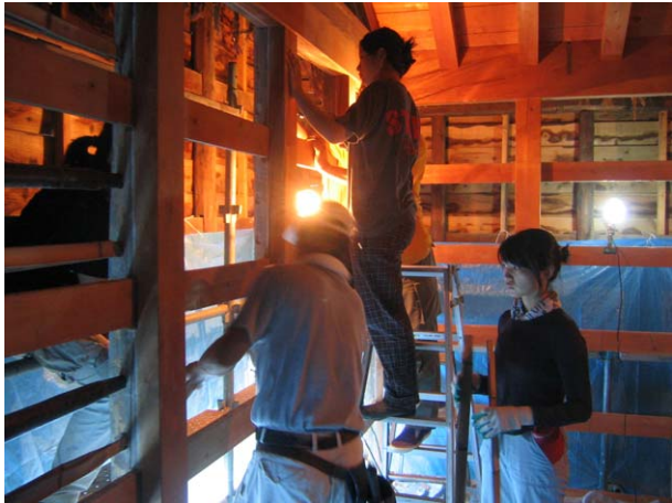
間渡しの受け口をドリルで穴開け
