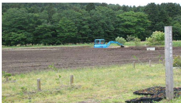
(ビオトープ開削状況)
