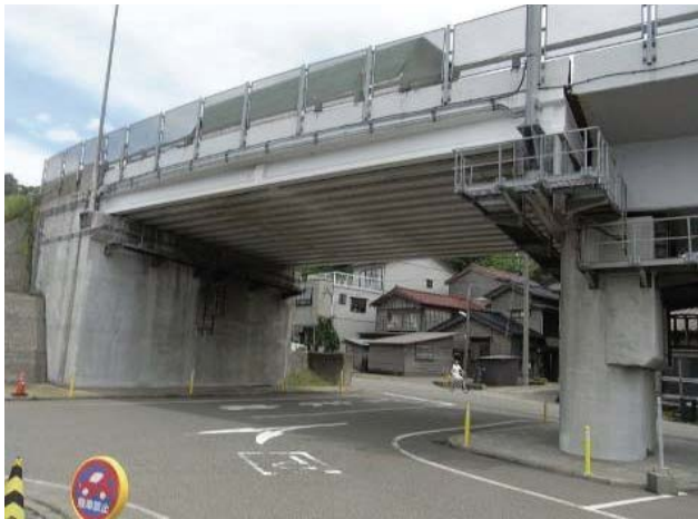
対策工事着手前
