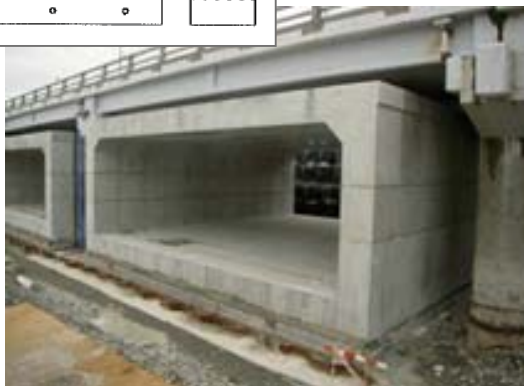
大型ボックスカルバート (内空 B 10.0m × H 3.4m)
