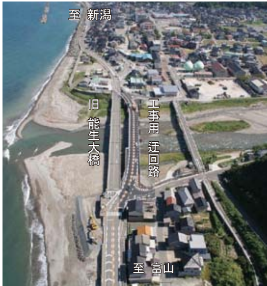
旧 能生大橋（迂回路仮橋設置状況）
