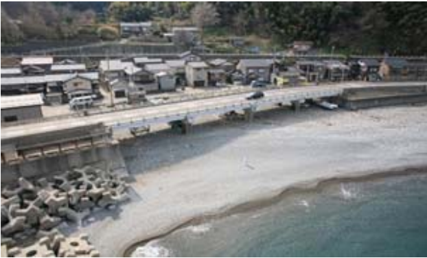
対策工事着手前（海側より）
