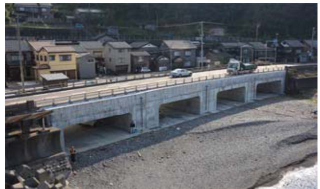
対策工事完了（海側より）
