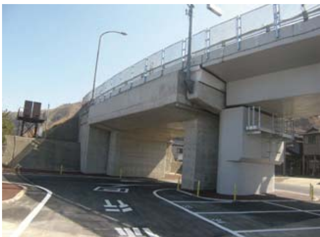
対策工事完了
