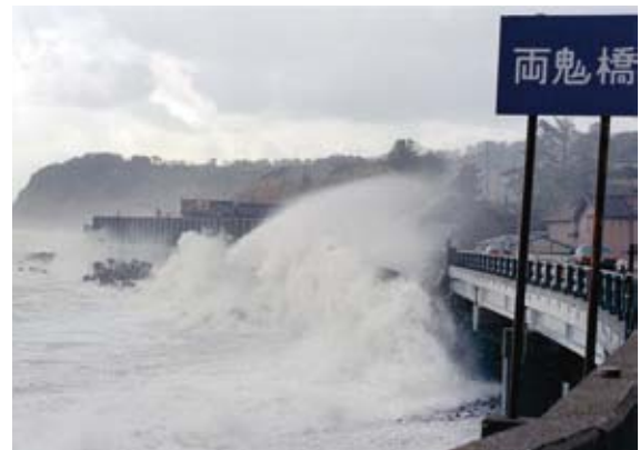
波浪を受ける道路（国道8号両魁橋）
