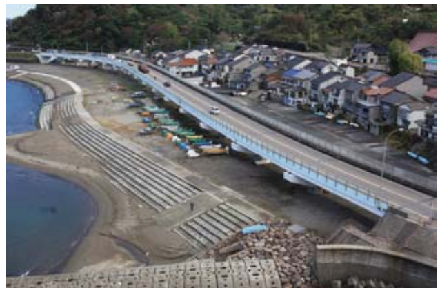
国道 8 号 弁天大橋
