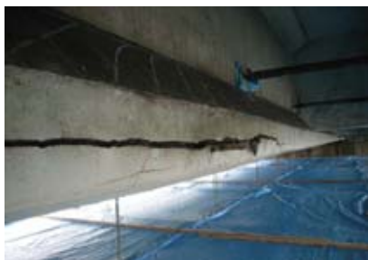
コンクリート橋の亀裂 （国道8号 能生大橋）
