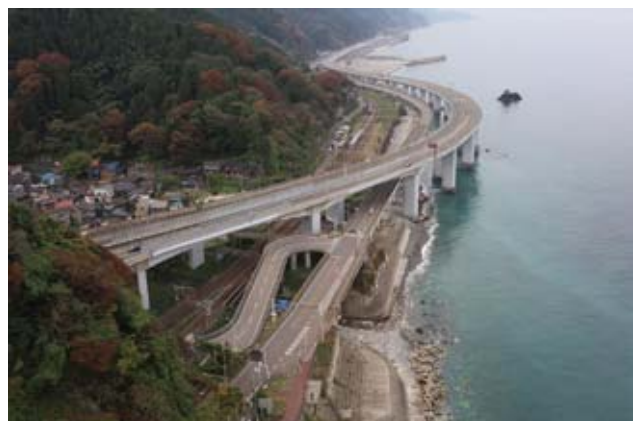
国道 8 号 歌高架橋
