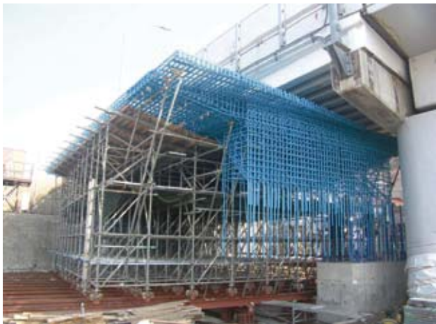
鉄筋等の引き込み状況
