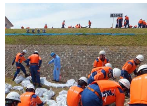
水防訓練での工法指導
