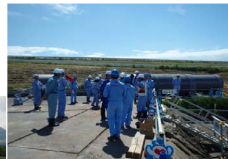
国土交通省との 合同現場巡視
