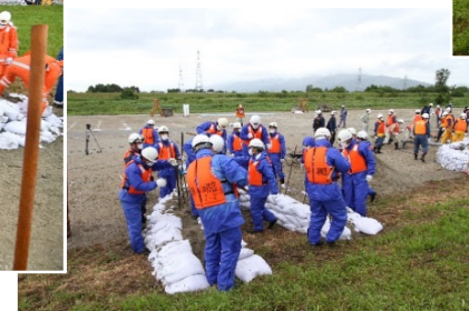
釜段工/月の輪工/シート張り工
