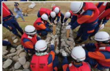
水防工法 (川倉工/木流し工 /立て籠工)
