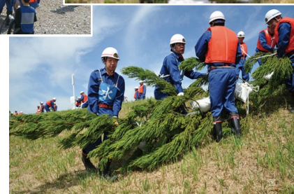
水防工法 (川倉工/月の輪工 /木流し工)
