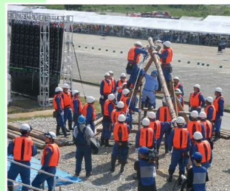
水防工法 (川倉工/月の輪工 /木流し工)
