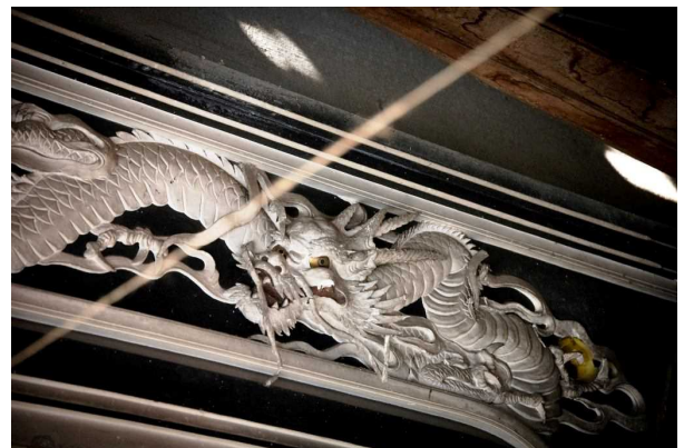
図6 奥の土蔵には立派な龍の漆喰彫刻が残っている。
