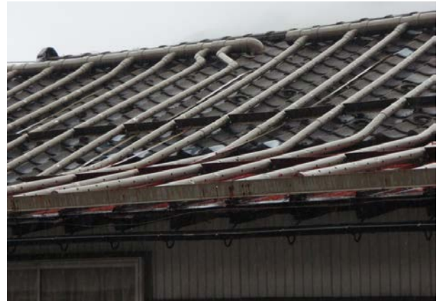
写真3 屋根雪融雪装置(温風型)
