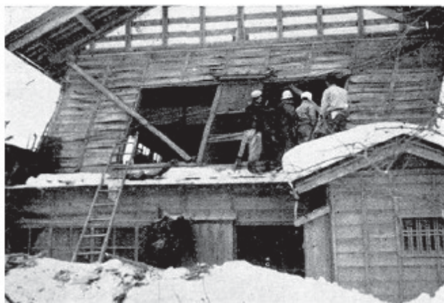
写真 序-1-2 2階部分のみが傾斜した家屋
