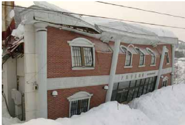
写真 序-1-1 雪の重みで倒壊した建物(北海道夕張市)
