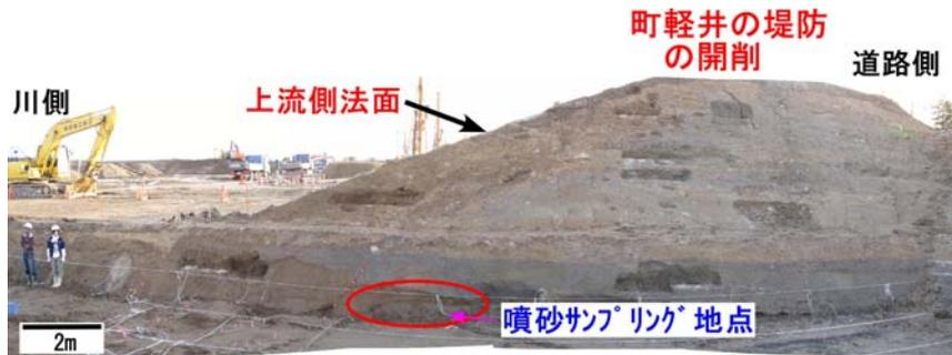
図10. 上流側の法面と調査した噴砂試料の採集場所
