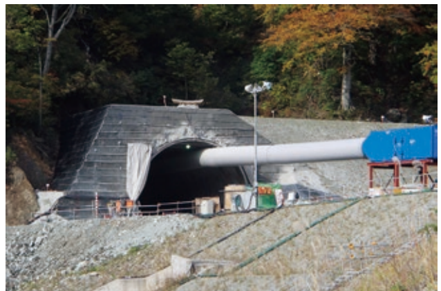
7号トンネル工事状況
