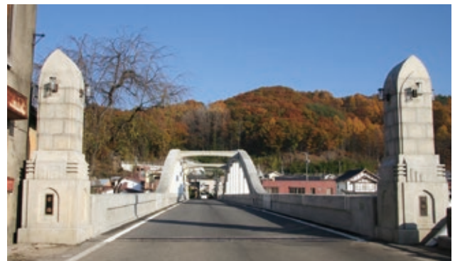
栄橋（左岸から正面）
