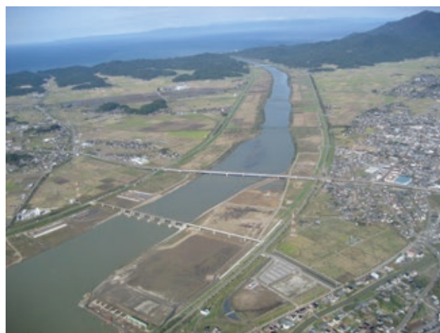
大河津分水全景（平成 25 年 10 月 23 撮影）
