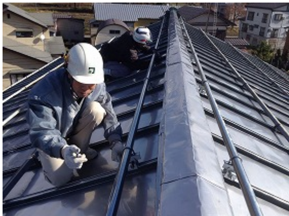
写真4 アンカー(単管)の設置
