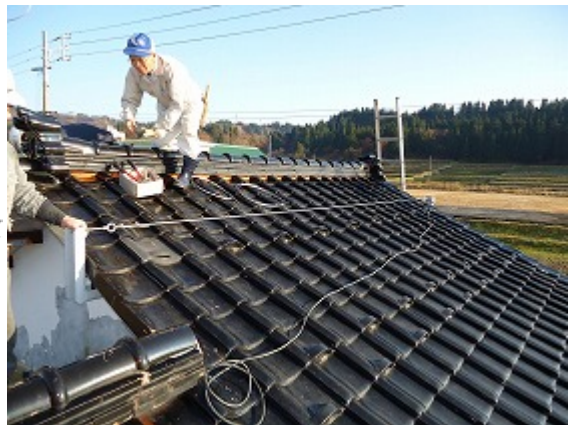
写真6 アンカー(ワイヤータイプ)の設置
