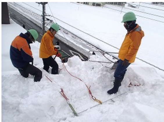
写真7 ワイヤー式アンカーの実証実験
