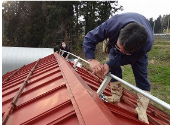
写真5 アンカー(ガス管タイプ)の設置
