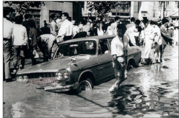
液状化で道路が冠水した新潟市中心部（中村勝典氏撮影）
