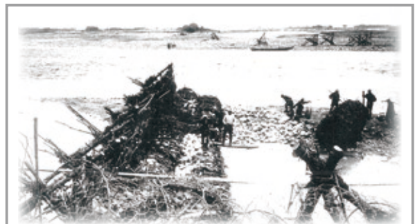
能美郡山上村字出口地内梅ノ木堤防決壊箇所ヨリ下流水田ヲ望ム 七月十九日(現在の能美市出口町) 出典:「石川県大水害写真」(昭和9年 石川県発行)
