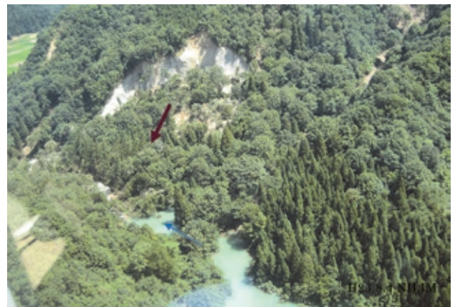
写真1 平成23年7月新潟・福島豪雨災害で発生した河道閉塞（三条市遅場）
