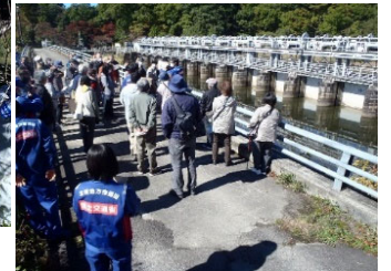
戸ノロ十六橋水門
