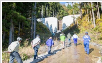
裏堀沢砂防堰堤
