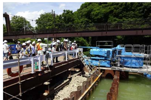
作業ヤードから締切工を望む
