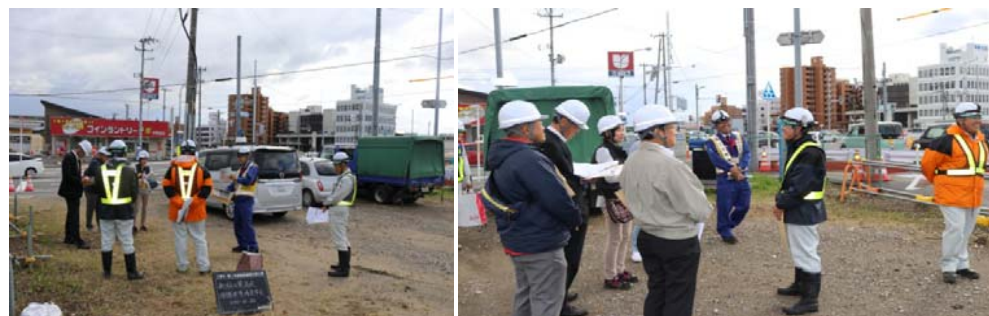
国道7号栗ノ木道路事業現場／高校OBと意見交換
