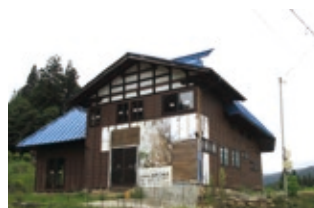
残った古民家を「隣の家」と呼び交流拠点として再建中
