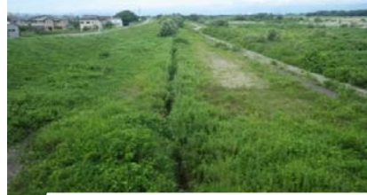
現地踏査→水路整備→整備後
