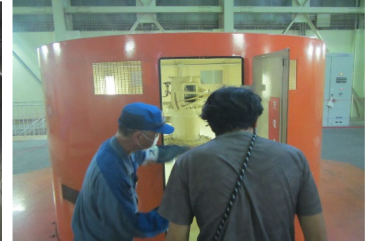
大町発電所内部見学
