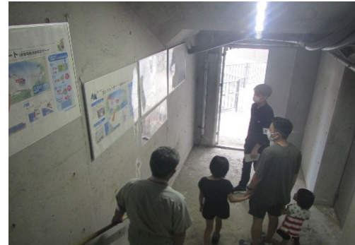
ダム内部見学
