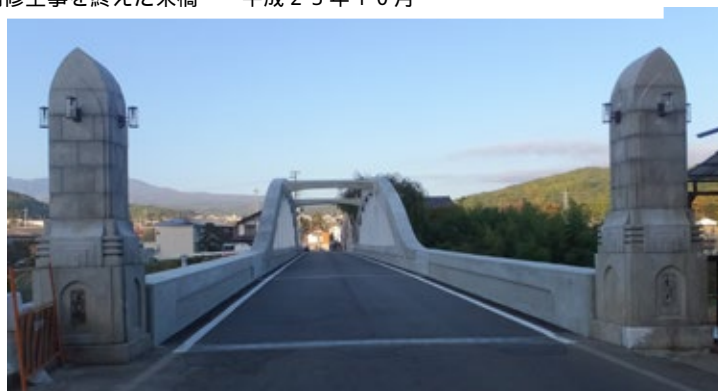
補修工事を終えた栄橋 平成25年10月
