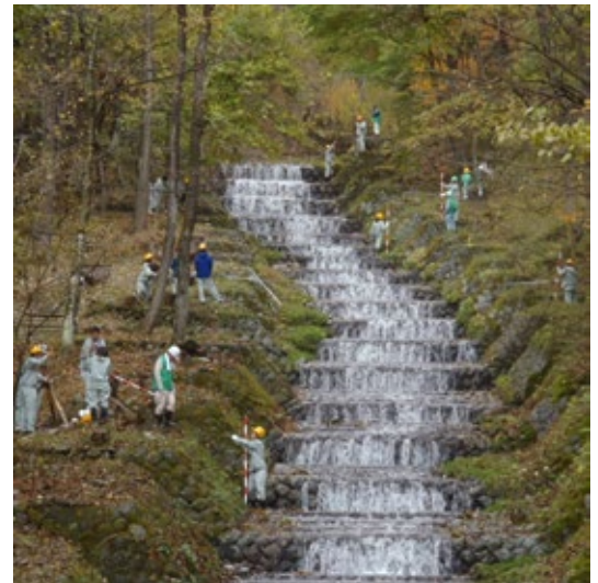
牛伏川階段工の測量に取り組む 長野高専の学生
