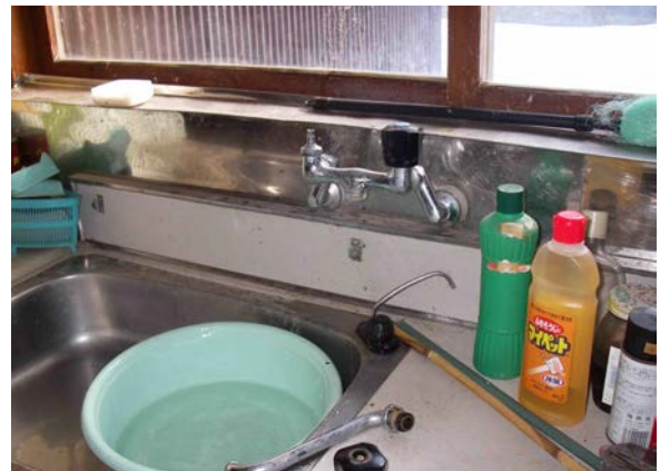
蛇口のパッキンが壊れていたため交換
