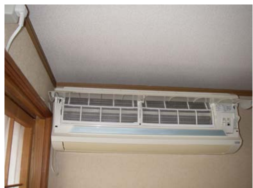
エアコン点検・修繕
