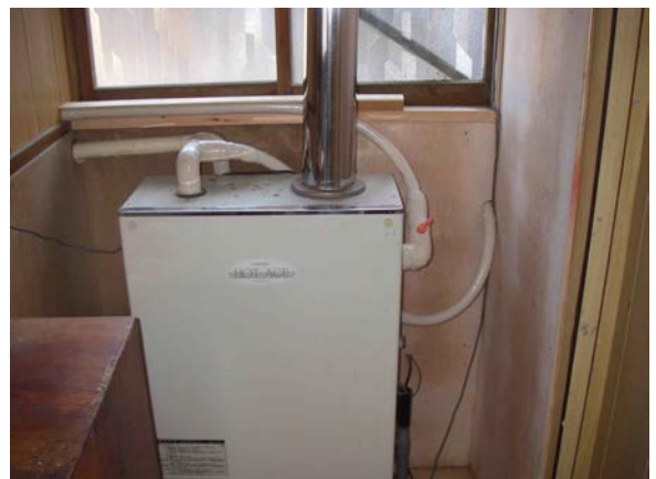
周りの板材を張り替え、配管を新しくするとともに保温処理加工を行った
