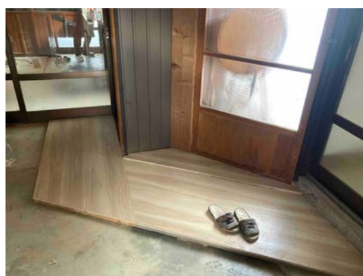
土間部分に板張りの通路を新しく設置。風呂場との行き来をやすくした
