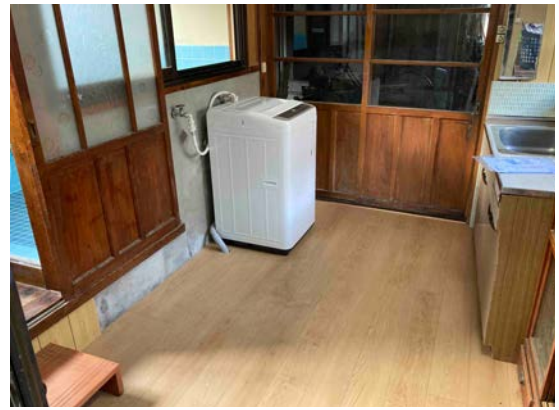
床をフローリング材に張り替え。洗濯機全自動新規購入。
