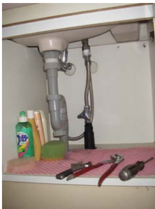
台所排水水漏れ箇所修繕
