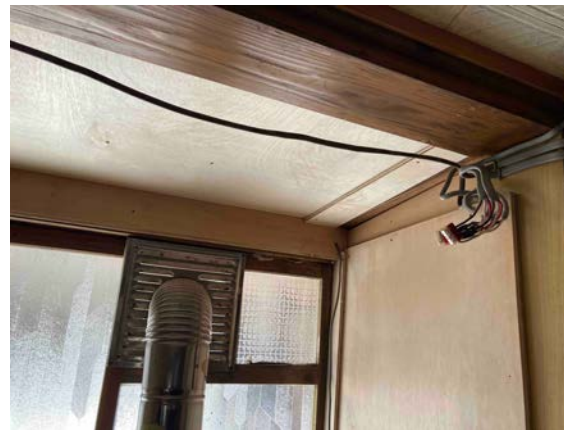
天井を張り替え、トタン屋根の補修、電気配線の整備を行った
