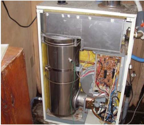
ボイラの温度センサーが壊れていたため交換
