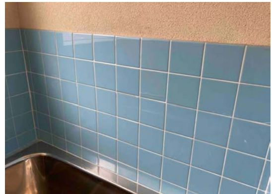
破損していたタイルを左官作業にて補修
