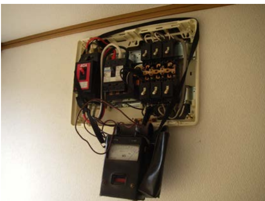
ブレーカー点検・修繕
