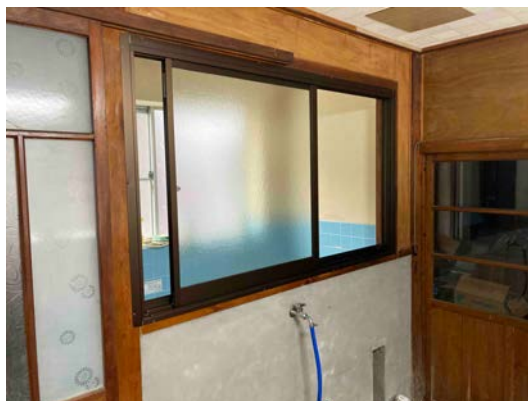
廊下に面する窓をアルミサッシに取り替え、保温性を高めた
