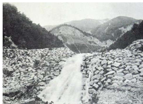
写真4 明治 20 年頃に建設された牛伏川の 石積堰堤（昭和 8 年牛伏川工事沿革史）
