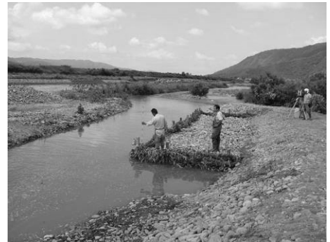
図 1 魚野川に造成した人工淵
