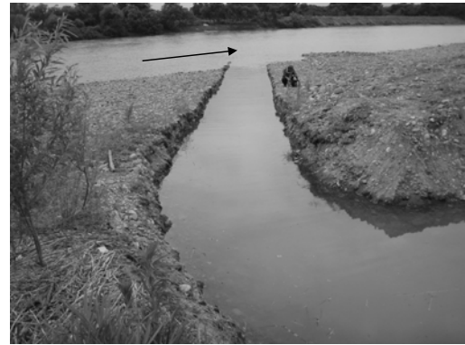
図5 人工淵と信濃川本流をつなぐ水路
