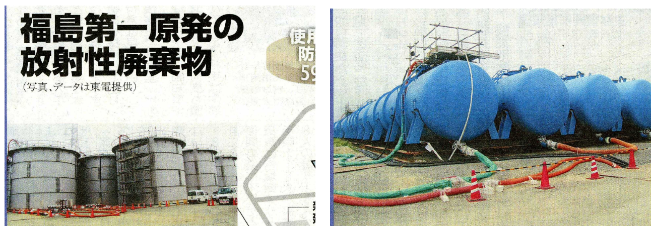
図1 福島第一原子力発電所では炉心冷却水や建屋地下に流入し放射性汚染された水が43万 ト 保管されている。一部の汚染水はALPS（アルプス）という除染装置で処理されているが、放射性トリチウムだけは除染できていない。
