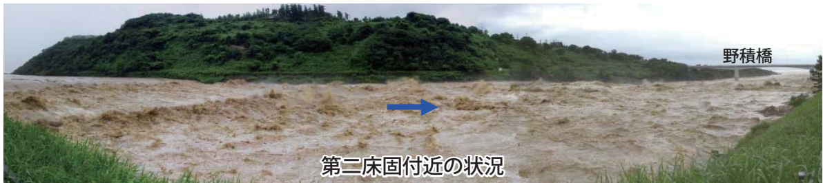
写真 4 平成 23 年 7 月洪水（第二床固）の状況
