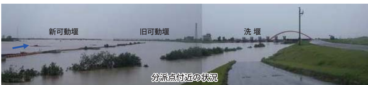
写真 6 平成 23 年 7 月洪水（大河津水分派点付近）の状況
