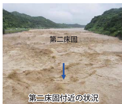
写真 5 平成 23 年 7 月洪水（第二床固）の状況
