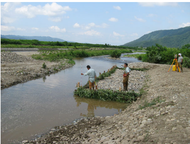
図2 完成した模擬護岸と人工淵
