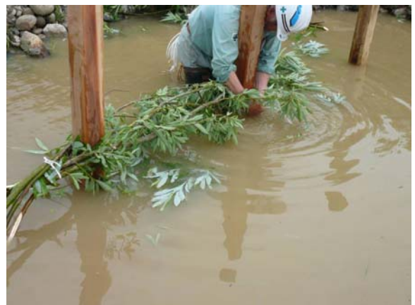
図3 ヤナギの枝で粗朶を組む
