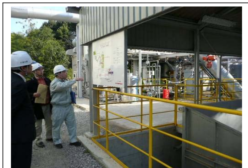
<仁淀川町バイオマス発電プラント>
