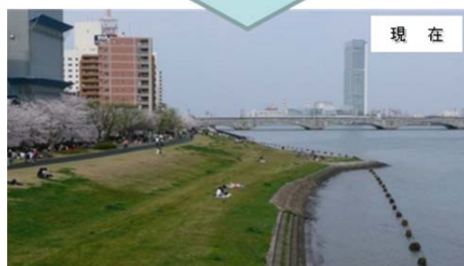
やすらぎ堤の整備（八千代橋から萬代橋を望む）
