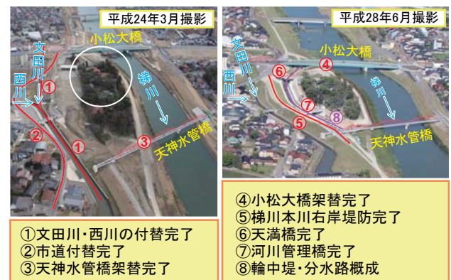
写真-6 分水路関連工事の実施状況
