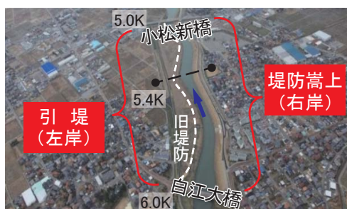
写真-3 小松新橋～白江大橋の堤防整備 (H24)
