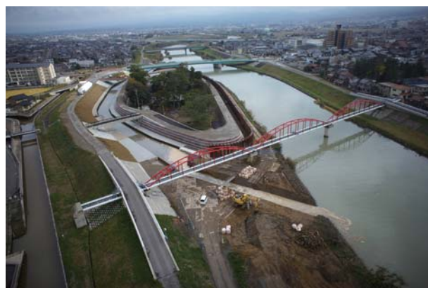
写真-9 ドローンによる通水の映像
