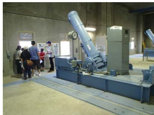
ダム内部見学
