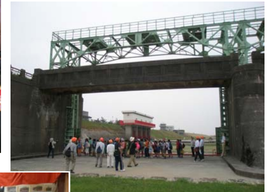
現地見学会(旧可動堰)
