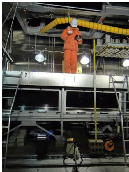
落下作業の様子
