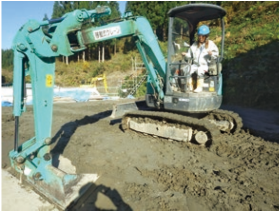
(株)多田組 渡辺さん／工事現場では大型の重機も乗りこなします。
