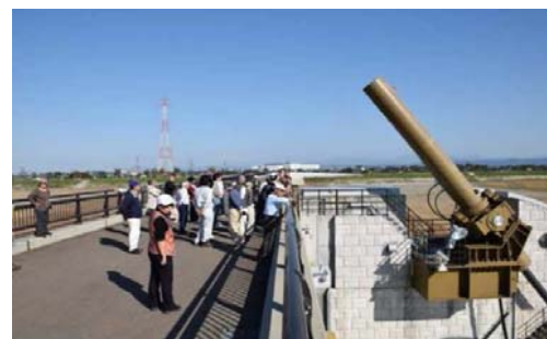
大河津分水可動堰
