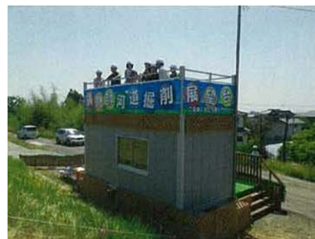
信濃川河道掘削工事現場の見学
