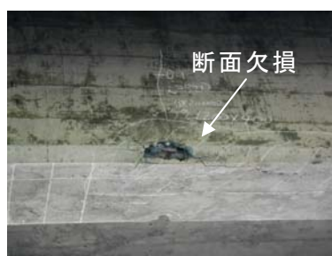
図 2 梁損傷状況
