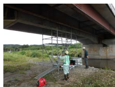
図 3 橋梁下部における計測状況
