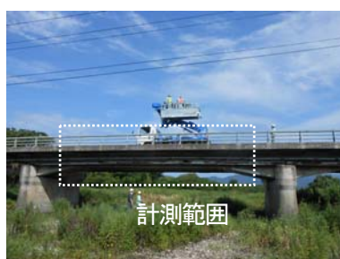
図 1 計測対象橋梁
