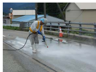
図 6 実験状況 (高圧水噴射)
