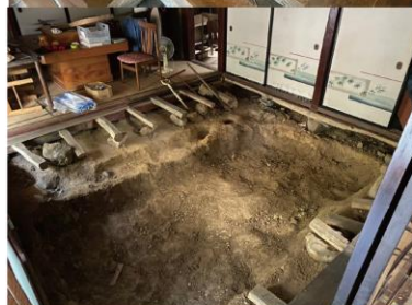
05. 床下土砂撤去 令3年10月18, 21日
