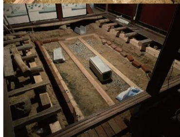
10. 煙突用U字溝敷設 令3年11月26日
