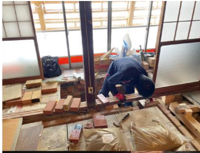
13. 床下地板調整 令3年12月19日
