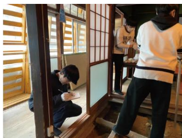
01. 解体・実測作業 令3年01月26-28日
