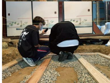
08. 土台板敷設 令3年10月27日 11月5日
