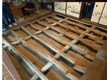
04. 床組み解体作業 令3年10月17日
