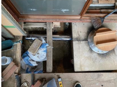
15. カマド煙突設置 令4年3月7日
