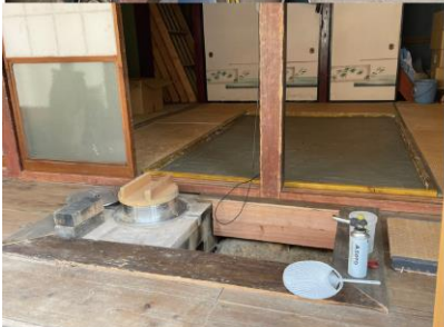
16. 床 叩き仕上げ下地 令4年3月10, 12日
