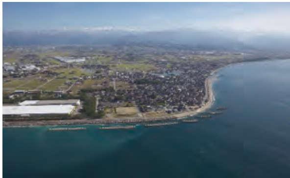
図-4 富山湾を守る有脚式突堤・有脚式離岸堤 (黒部市生地地区)
