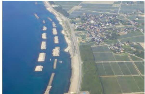
図-6 背後地を守る離岸堤・副離岸堤 (入善町吉原地区 平成29年6月現在)
