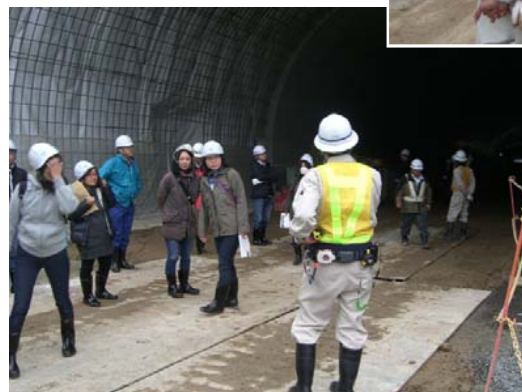
磐越道 吉津トンネル工事
