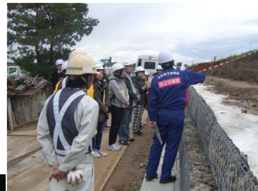
六郷堤防浸透対策工事
