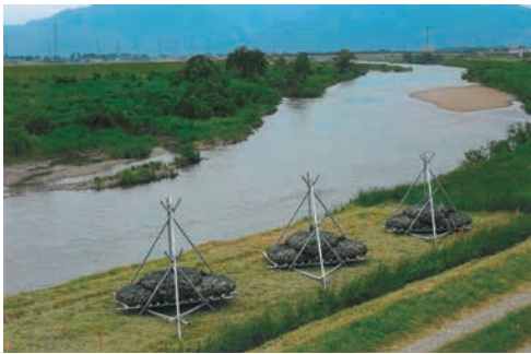
阿賀野川左支川早出川における試験施工（五泉市）
