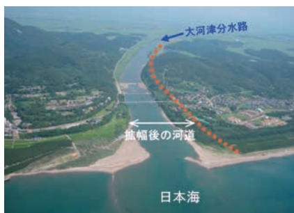
信濃川大河津分水路改修
