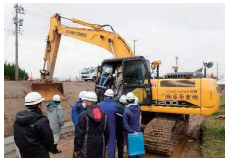
ICT活用工事見学会 ICT施工(MGバックホウ)法面成形の搭乗体験
