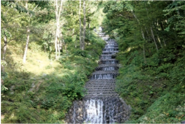
牛伏川フランス式階段工（松本市）
