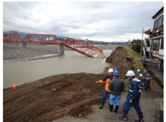
応急復旧状況の確認（上田電鉄 千曲川橋梁 付近）
