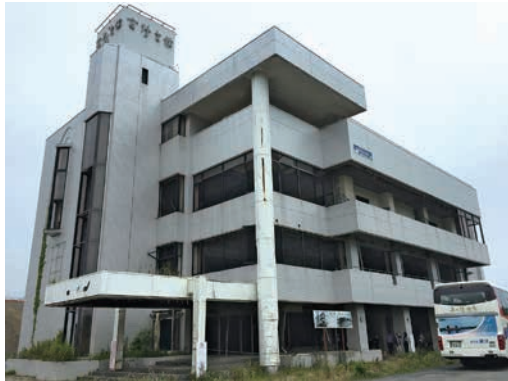
4階まで津波に襲われた「高野会館」
