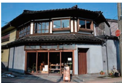
東橋のもとにあった畳屋を改修した カフェ uchikawa 六角堂
