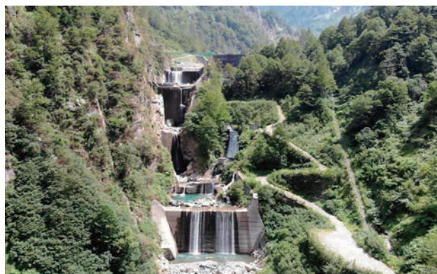
白岩砂防堰堤 常願寺川上流に大量にある不安定土砂を抑える基幹施設 (写真 北陸地方整備局立山砂防事務所提供)
