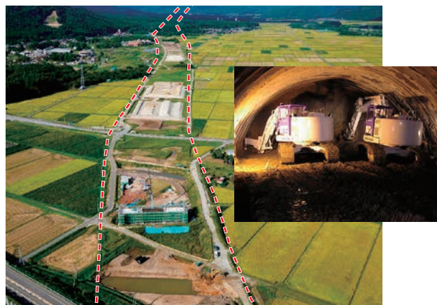
整備を進めている日本海沿岸東北自動車道
