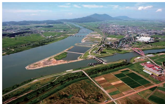
当時の土木技術を駆使して建設された 大河津分水路
