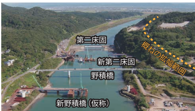
大河津分水路改修事業
