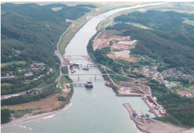
大河津分水路河口部全景
