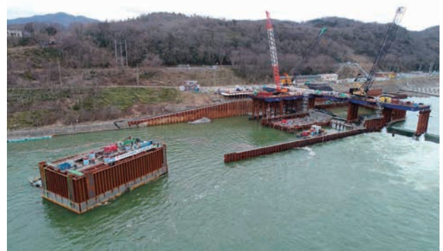
巨大な鋼殻ケーソンの移動状況
